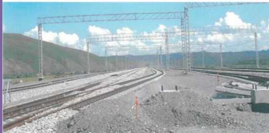
Реконструкция станции Карымская Забайкальской железной дороги. Нечетный приемо-отправочный парк
